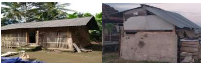
Gambar 1. Foto gudang Tradisional penyimpanan umbi kentang: kiri . Gudang penyimpan umbi kentang di Desa Setiling, Kabupaten Lombok Tengah; kanan . Gudang penyimpan umbi kentang di Desa Santong, Kabupaten Lombok Utara
