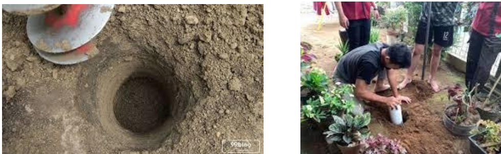
Gambar 3. Pembuatan lubang biopori
