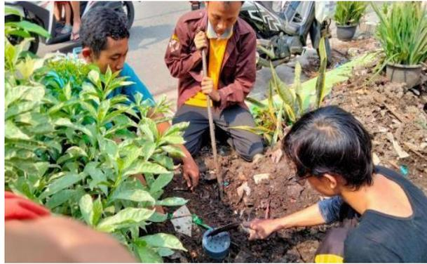
Gambar 4. Pemasangan Biopori
