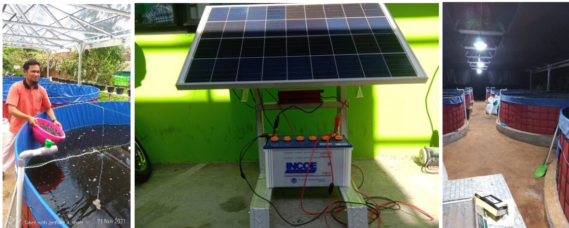
Gambar 4. Aplikasi TTG di kolam perikanan Pokmas PSDA, dengan lampu berbasis tenaga surya
