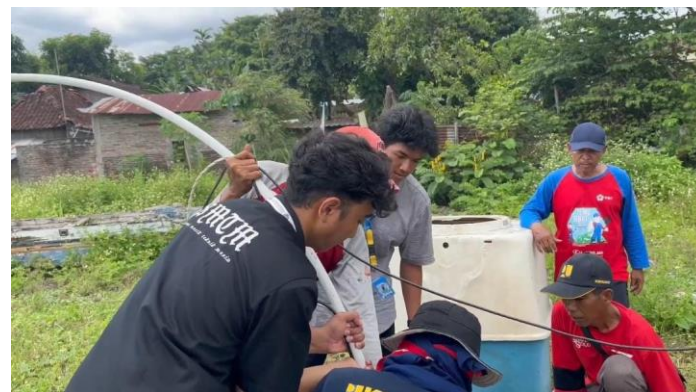
Gambar 4. Pemasangan Pipa Air Bersih Bersama Warga Pada Jalur Prioritas.
