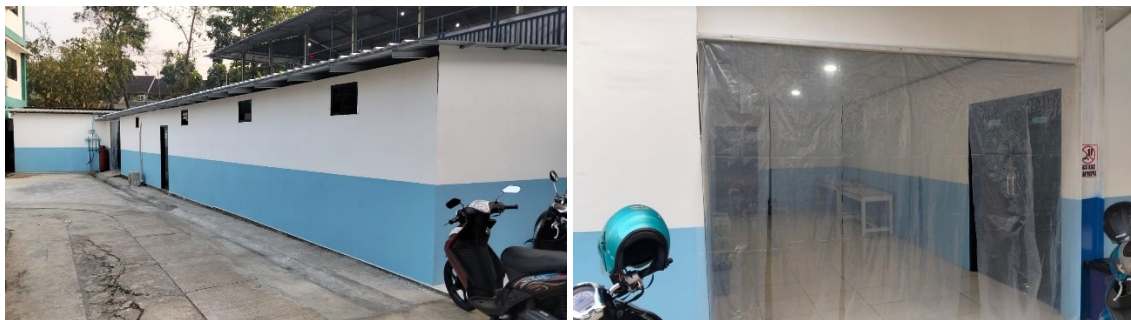
Gambar 6. Kondisi Dapur Ponpes Al Huda Sesudah Renovasi
