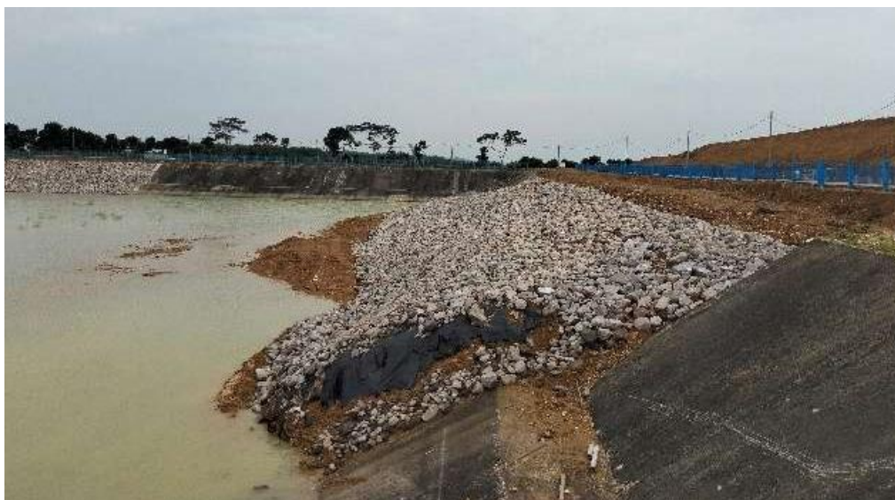
Gambar 2. Kelongsoran kolam penenang menggunakan riprap
