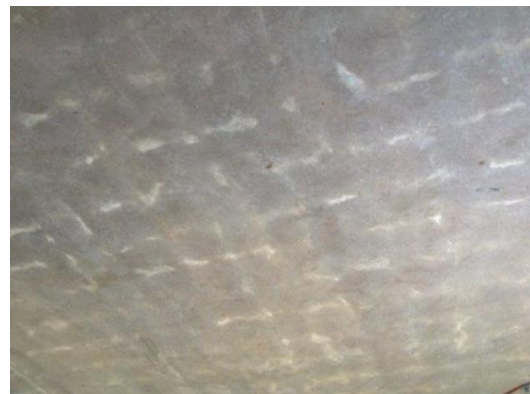
Gambar 1. Retak Plastik
