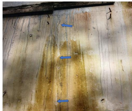
Gambar 10. Posisi Retakan
